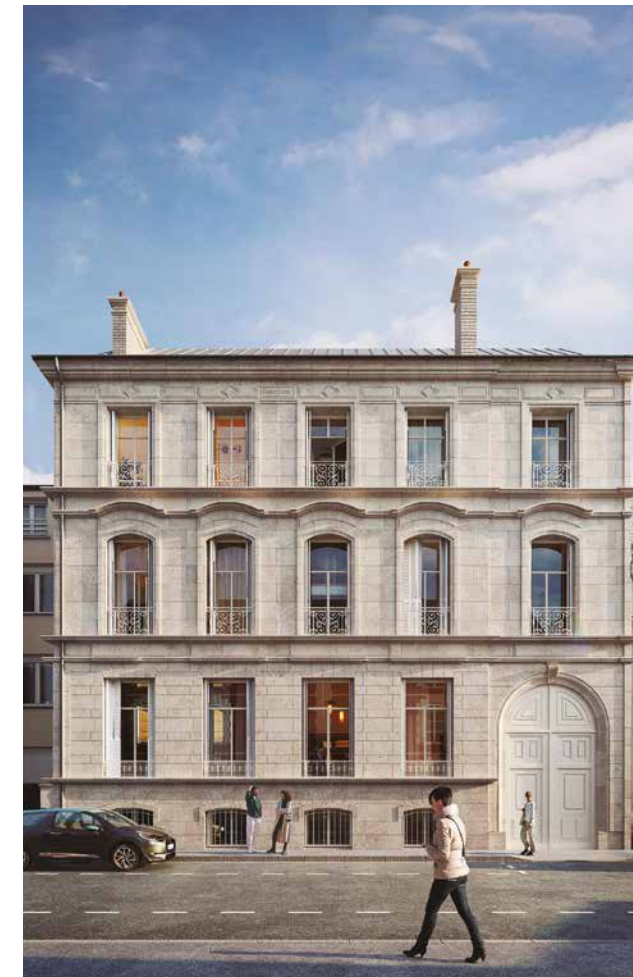
Maison Commandeur Reims
